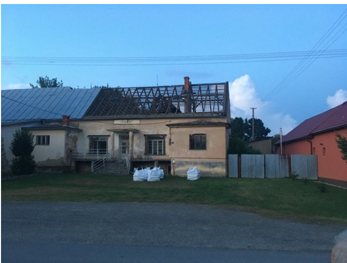
Práce na oprave strechy – foto: Mgr. Ložanský
