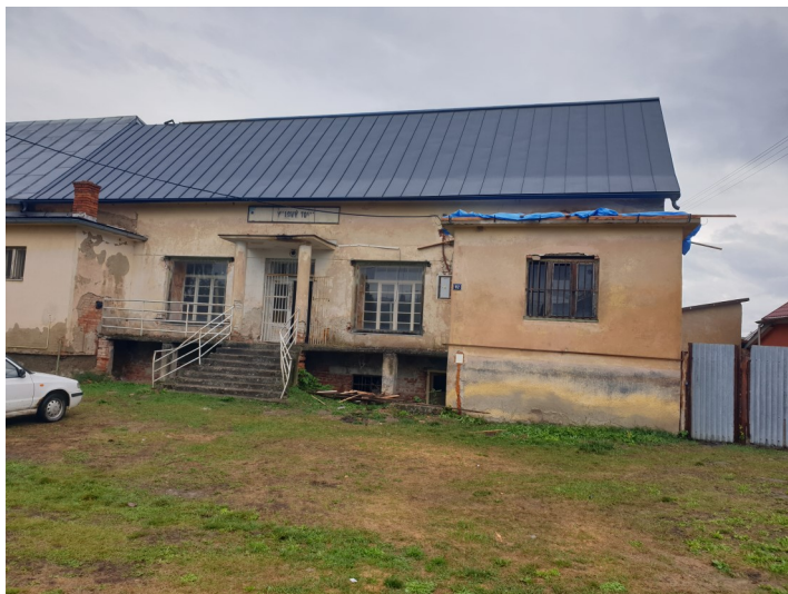
Rekonštrukcia strechy „Železný obchod“. Foto: Bc. Stela Lörincová
